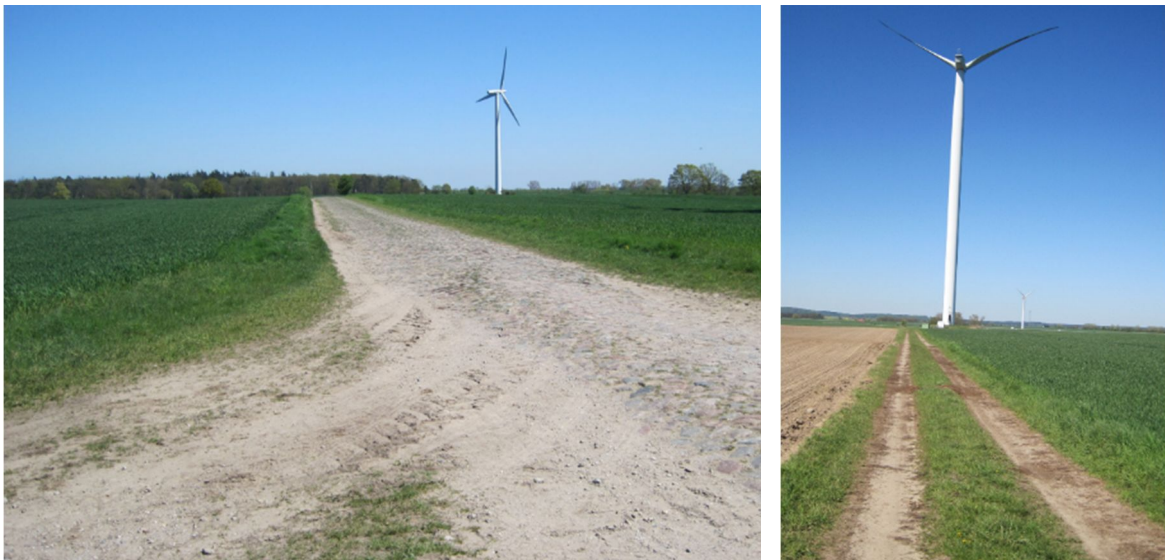
Abbildung 22: Verbindungsweg von der Gemeindestraße nach Neuhof (l.) u. Erschließungsweg für die WEA (r.)
